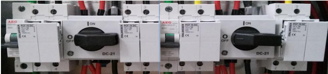
Quadro elettrico Ston
